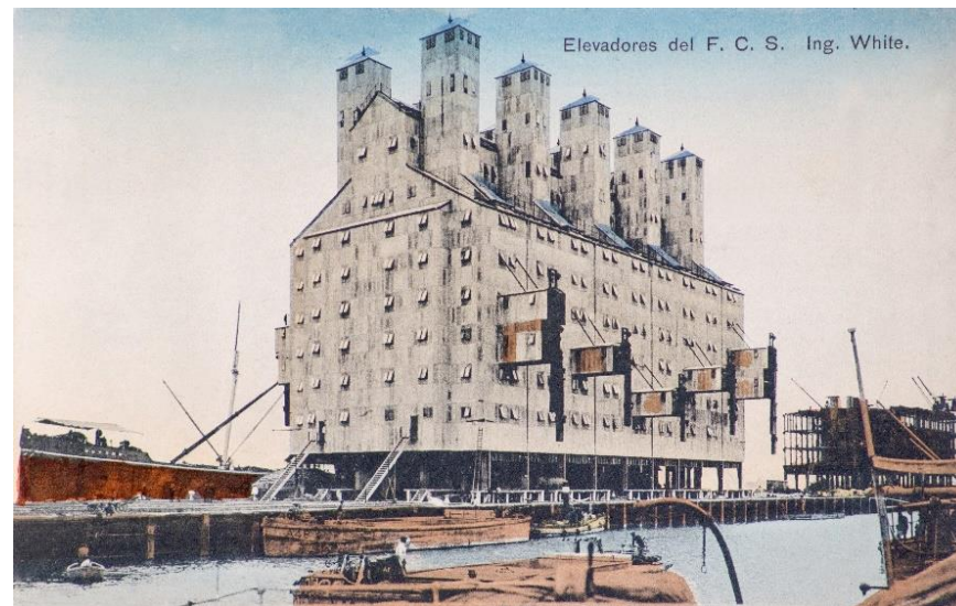
Elevador Nro. 1; se observa al elevador Nro. 2 todavía en construcción.
